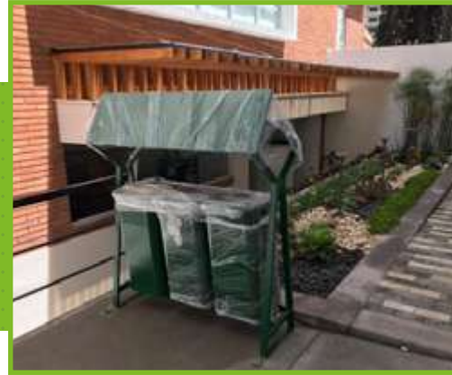
Instalación ecopuntos HUB-iEX
